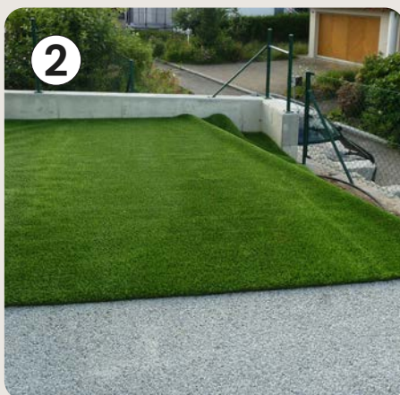
2 Ausrollen des Rasens
