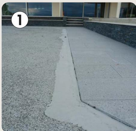
Béton avec gravillons & lit de mortier
