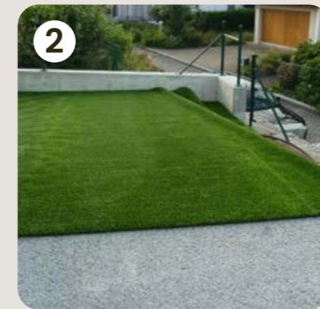
2 Ausrollen des Rasens
